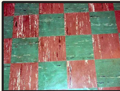
9 x 9 vinyl asbestos tiles - VAT
